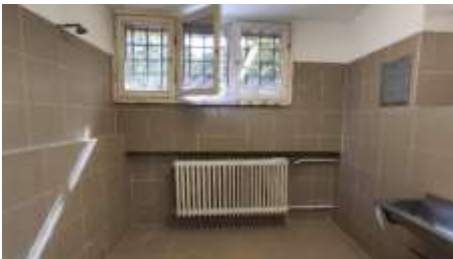
16. kép. Felújított vizesblokk, mázolásra váró ablakok
