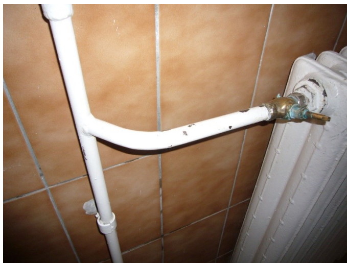
15. kép: festékkopás a radiátor csövén
