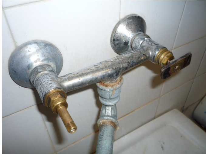
4. kép: balesetveszélyes, hegyes csap
