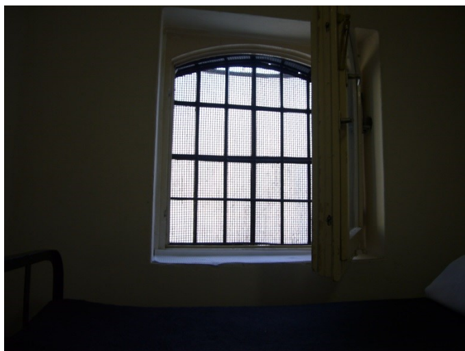
6. kép: kilátásgátló a zárkaablak előtt
