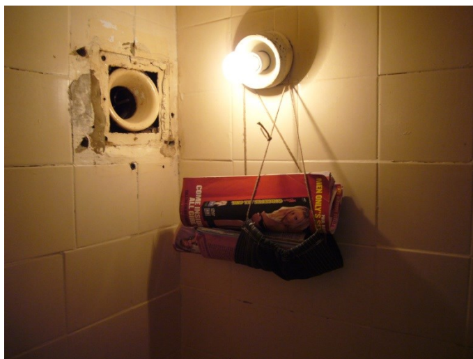
19. kép: a szellőző hiányos borítása
